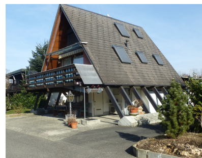
Exemple type de pavillon présent dans la zone
