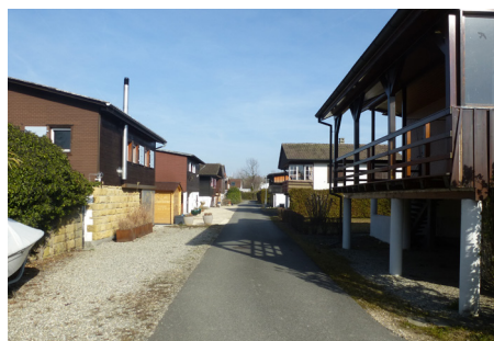
Les pavillons de vacances, allée typique de la zone
