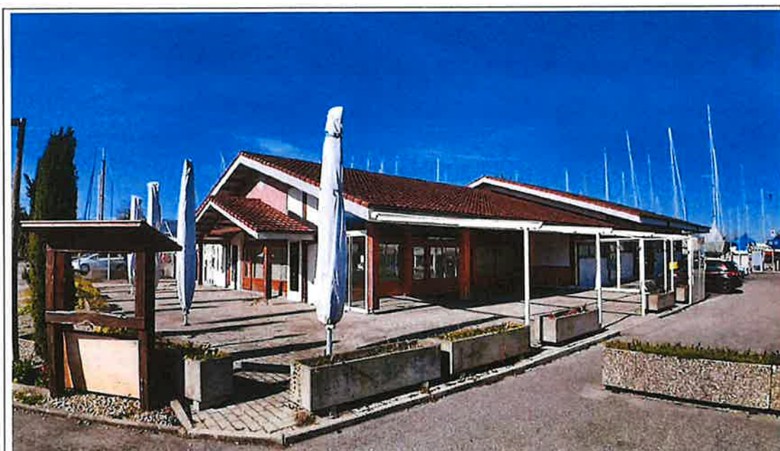
Vue extérieure générale (source dossier IVAC).
