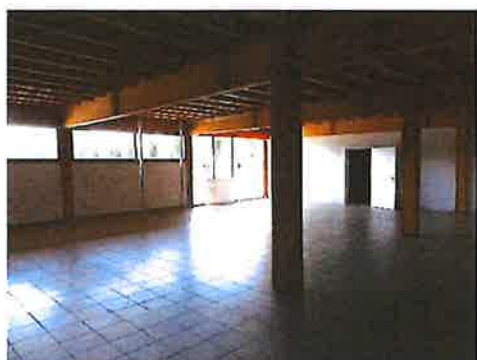
Magasin (vue côté accès clients)
