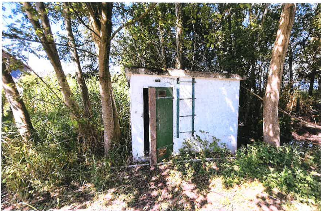
Figure 5: Vue extérieure du bâtiment
